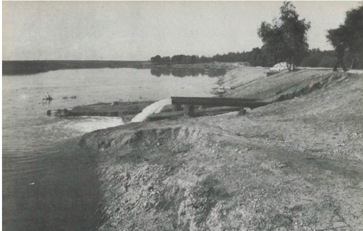
Εικ. 59. Το φράγμα Αγίου Λουκά που λειτούργησε το 1955. Φωτογραφία άγνωστου φωτογράφου, άγνωστης χρονολογίας (Χριστοφίδης, Κύρου, Πιστή κ.ά. 2009, σ. 27). © Τμήμα Αναπτύξεως Υδάτων
