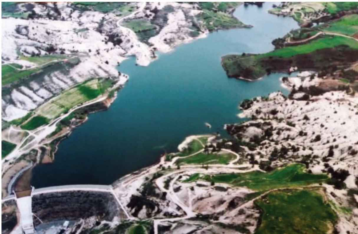
Εικ. 11. Το φράγμα της Ταμασού, 2001, Αρχείο Τμήματος Αναπτύξεως Υδάτων. © Τμήμα Αναπτύξεως Υδάτων
