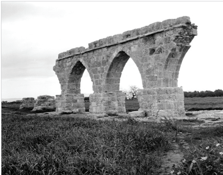
Εικ. 55. Τμήμα του πέτρινου υδραγωγείου που μετέφερε νερό από την Κυθρέα στη Σαλαμίνα. Φωτογραφία άγνωστου φωτογράφου, άγνωστης χρονολογίας. © Τμήμα Αρχαιοτήτων Κύπρου
