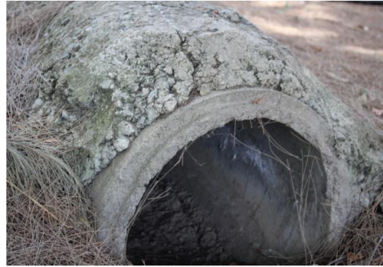
Εικ. 19. Σήραγγα νερού στο Γραμμικό Πάρκο, Στρόβολος, 2020. © Ευανθία (Εύη) Τσελίκα
